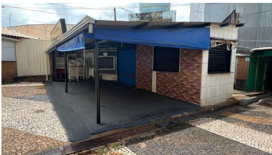
Imagem 02: Trailer Fixo de Lanches, localizado na Avenida Angelo Mioto, nº 50, no Lanchódromo Municipal.
