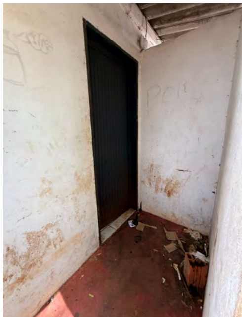
Imagem 5: Hall de entrada do sanitário masculino
