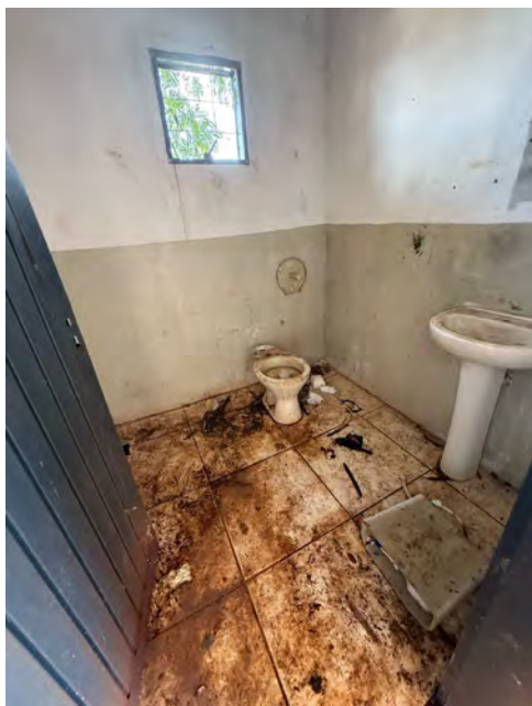
Imagem 6: Área interna do sanitário feminino
